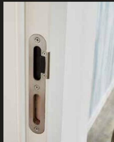
Detail: Magnetfallschließblech zum Verstellen
