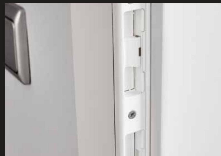
Detail: Schließblech mit Fallenverstellung
